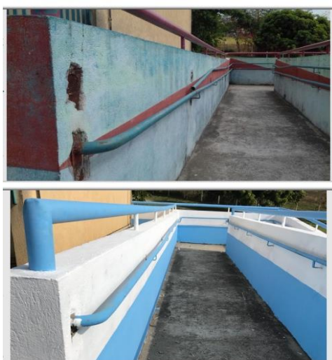
Figura 5. Revitalização da rampa de acesso
